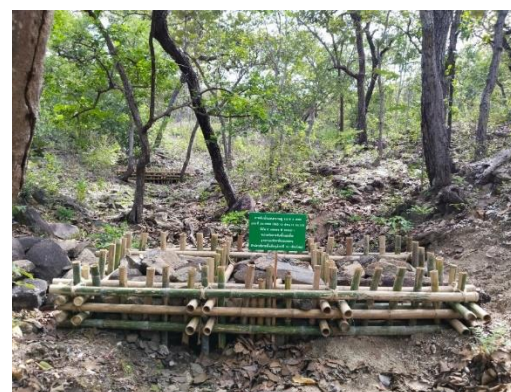
รูปที่ 5.1.3-5 การก่อสร้างฝายต้นน้ำแบบคอกหมู ขนาด 3 เมตร จำนวน 25 แห่ง
