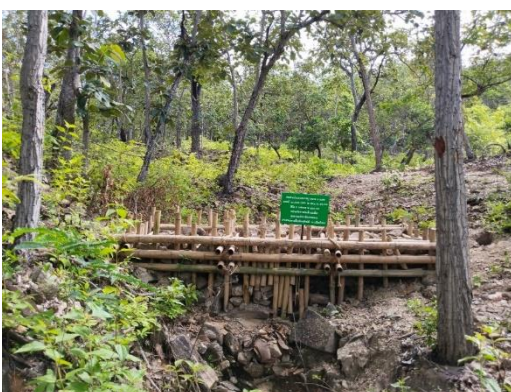
รูปที่ 5.1.3-5 การก่อสร้างฝายต้นน้ำแบบคอกหมู ขนาด 3 เมตร จำนวน 25 แห่ง
