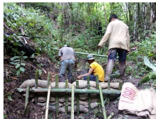
รูปที่ 5.1.3-2 ประมวลภาพผลการดำเนินการก่อสร้างฝายต้นน้ำลำธารแบบผสมผสาน
